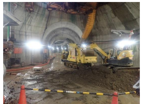
(主立坑深度 500m 接続部)
